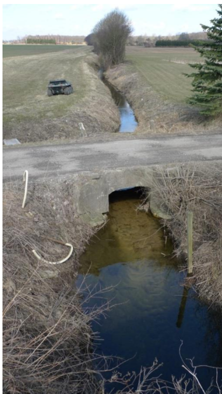
Figur 4-6 Billedet er taget mest nedstrøms fra jernbanebro mod nord (station 2138) og viser bundhævning som følge af sedimentaflejring og vandløbets karakter nedstrøms.
